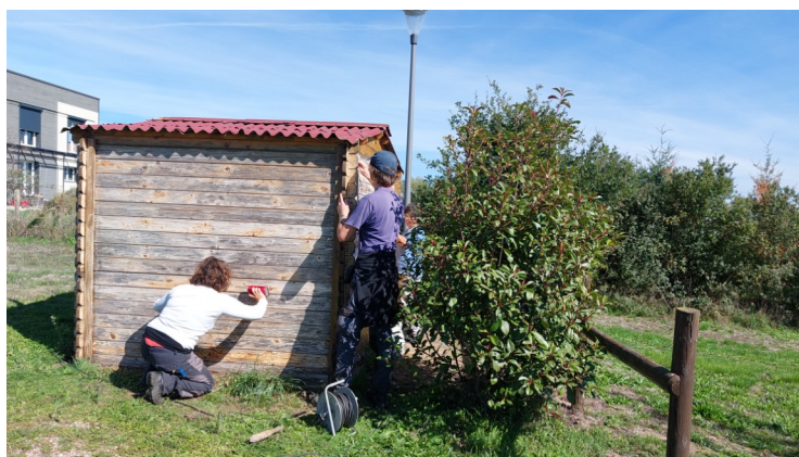
Lasure des toilettes de l'aire de jeux par un chantier d'insertion de la Communauté de communes Entr'Allier Besbre et Loire
